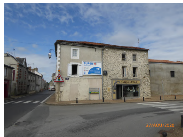
Dispositif installé sur un mur comprenant des ouvertures de plus de 0,50 m 2 , non admis par la réglementation nationale dans toutes les agglomérations
