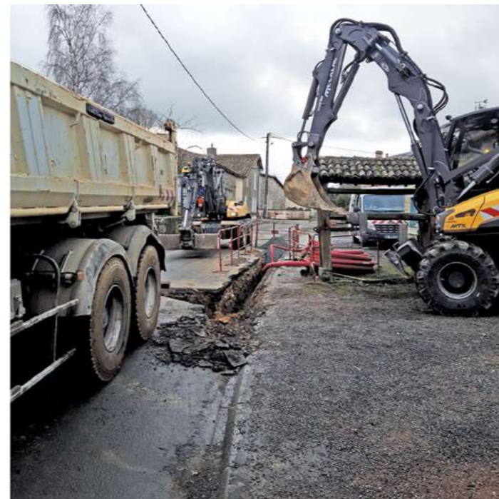
Effacement réseaux à Coutières
