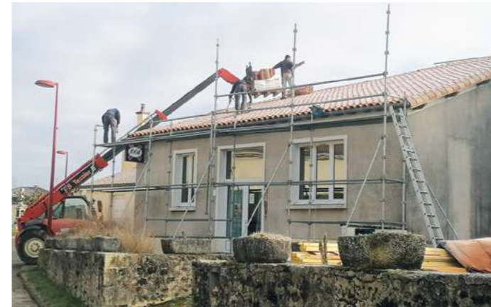
Réfection toiture à Chantecorps
