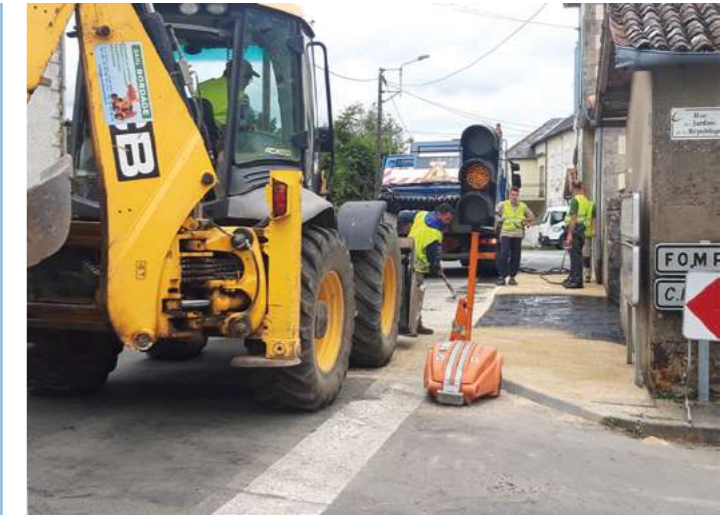
Mise en sécurité et aménagement à Coutières
