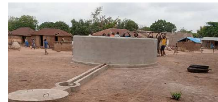
Les habitants aident à la pose des tuyaux du forage
