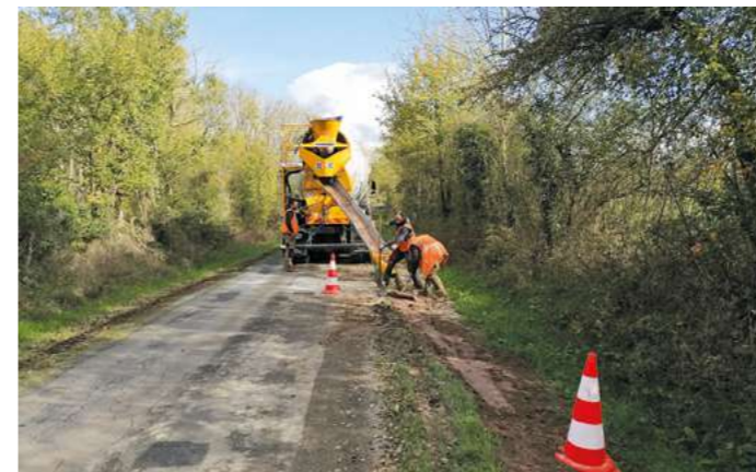
Enfouissement fibre route de l'Ifcom
