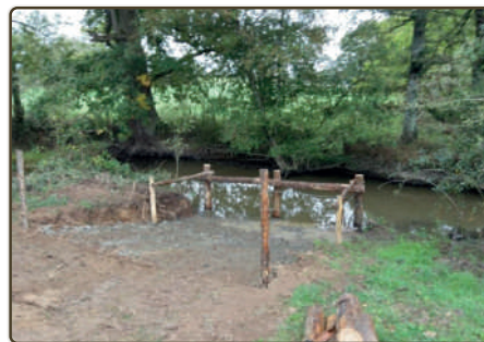
Abreuvoir aménagé sur le Cébron ©SMVT
