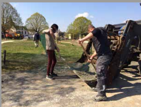
▲ Préparation de l'allée de l'école
