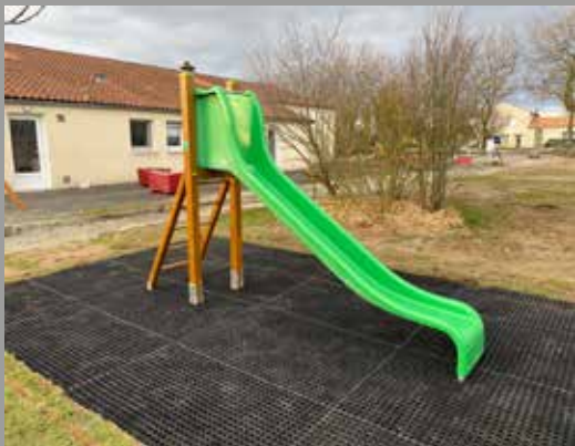
▲ Installation du toboggan avec tapis amortisseur
