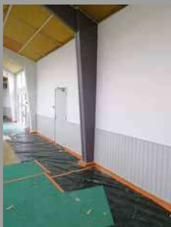
▲ Peinture des murs
