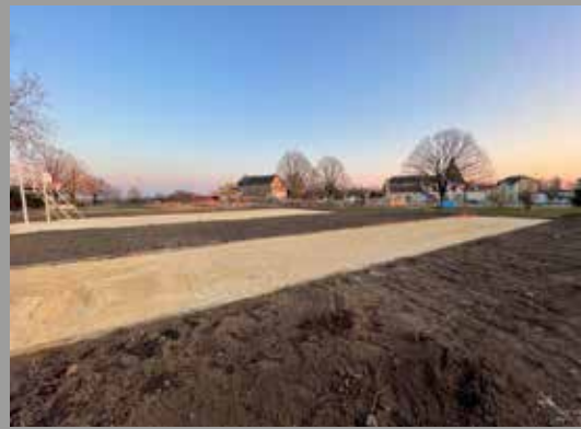
▲ Réalisation du terrain de boule
