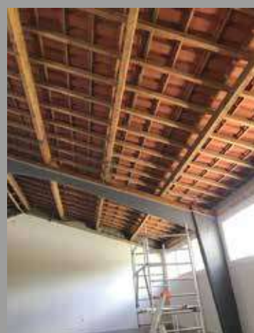
▲ Démontage de l'ancien plafond
