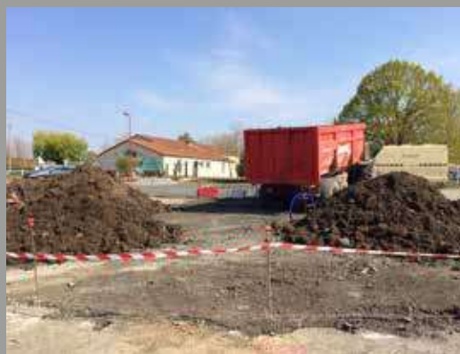
▲ Apport de la terre de l'îlot
