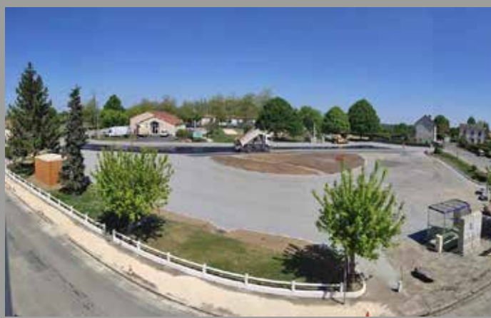
▲ Travaux de voirie : Bi-couche
