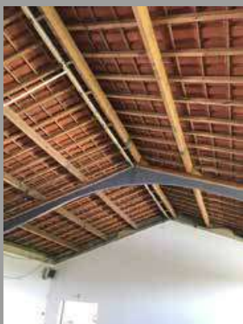
▲ Démontage de l'ancien plafond
