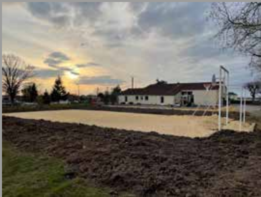
▲ Réalisation du terrain Multi-Sports
