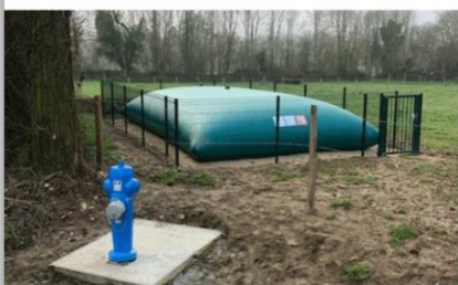
Exemple de réserve incendie
