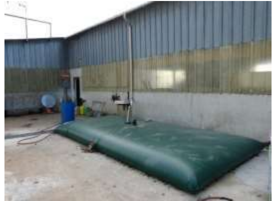
Bâche de 10 m 3 pour récupération des eaux de pluie aux ateliers municipaux
