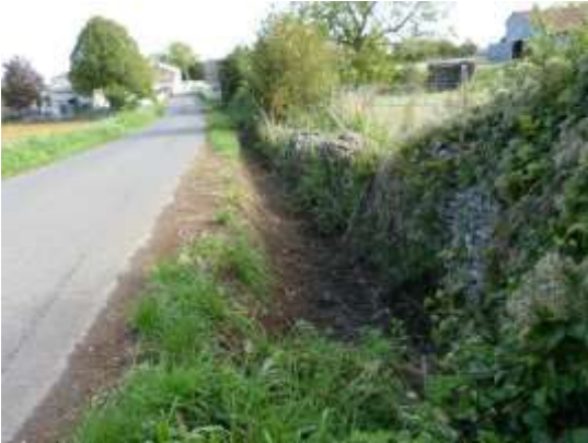
Curage fossé «Bas de Buzay»
