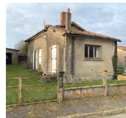
Le petit local pouvant être mis à disposition à Coutières.
